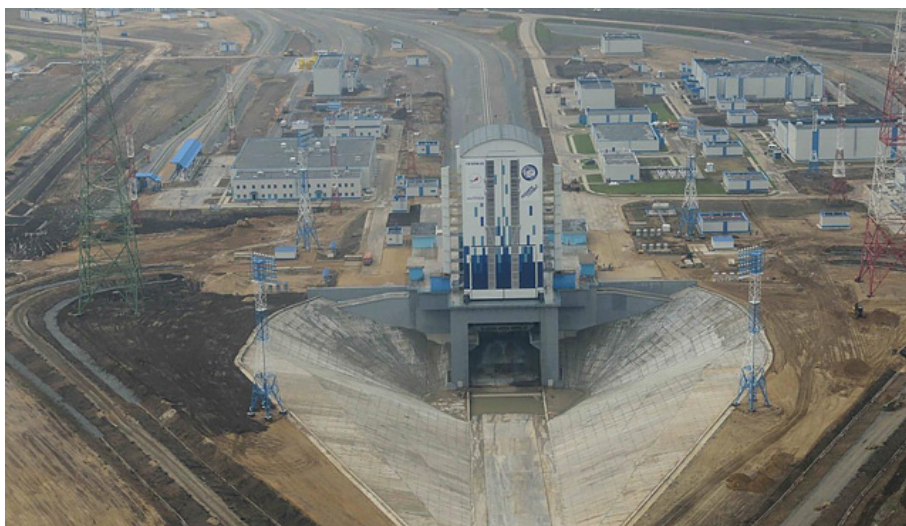
Stavba kozmodrómu „Vostočnyj“
