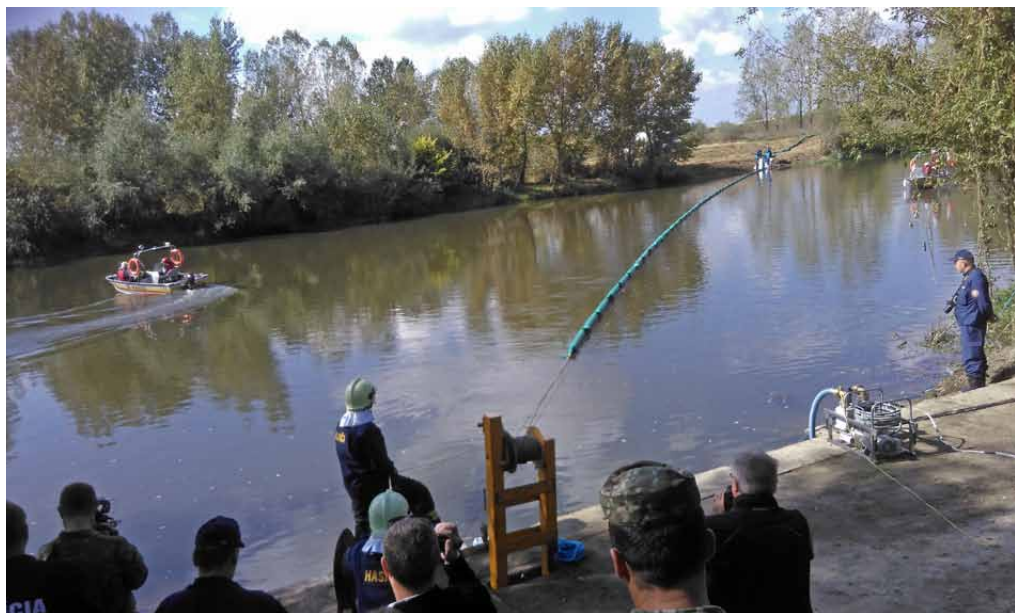
Výstavba nornej steny na rieke Hron
