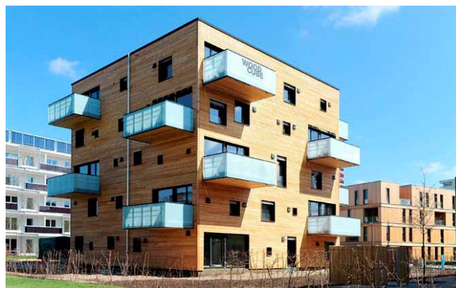
Obr. 2 Obytná budova z CLT (WALLACE, 2014)
